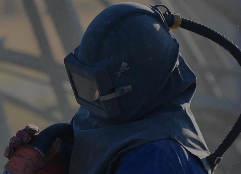
Le **sablage** est un procédé qui consiste à **projeter un abrasif** (sable) sur une surface **pour la décaper**, retirer l'oxydation ou un produit de recouvrement usé et créer une rugosité qui **permettra l'adhérence du produit de protection** appliqué par la suite.
